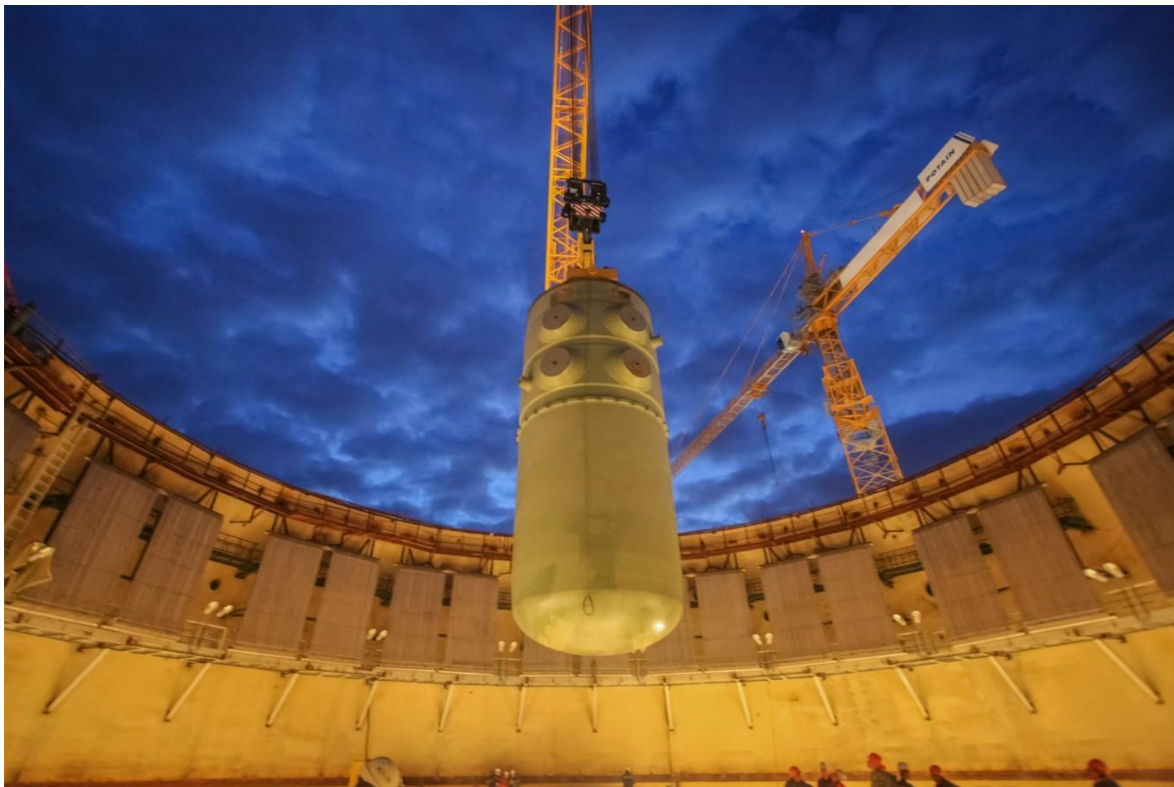
A passzív konténment hűtés hőcserélője
