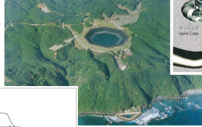
沖縄海水揚水プラント全景 Okinawa Seawater Pumped Storage Power Station
