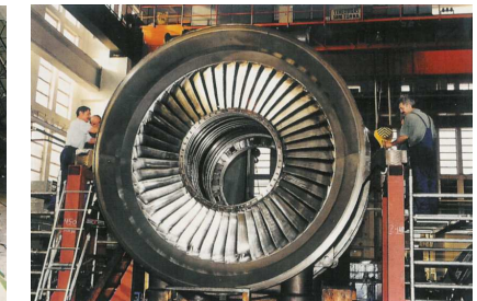
Százhalombattai 215 MW-os gőzturbina javítása
