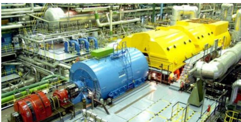
7.2. ábra. A turbina és a generátor: Sárga: turbinaház; Kék: generátor; Piros: gerjesztőgép [Bacscai P. foto 2]
