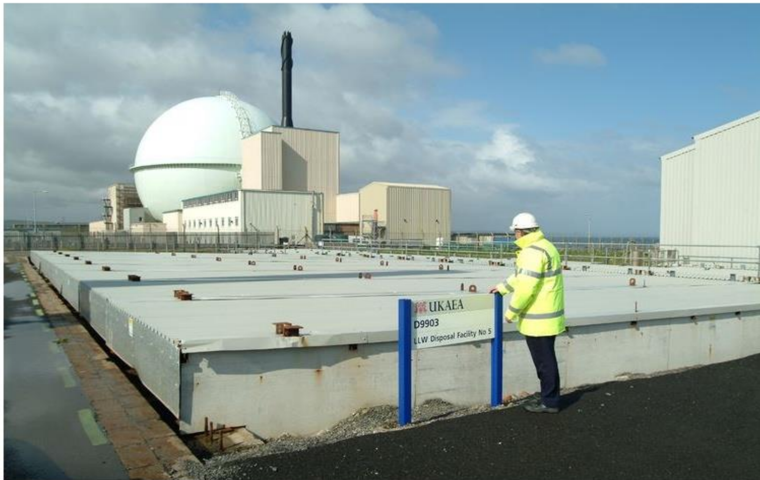
Dounreay's disused LLW pits
