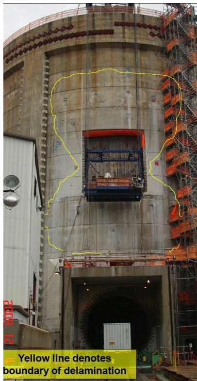
35. ábra Crystal River 3. blokk konténmentjének sérülése
