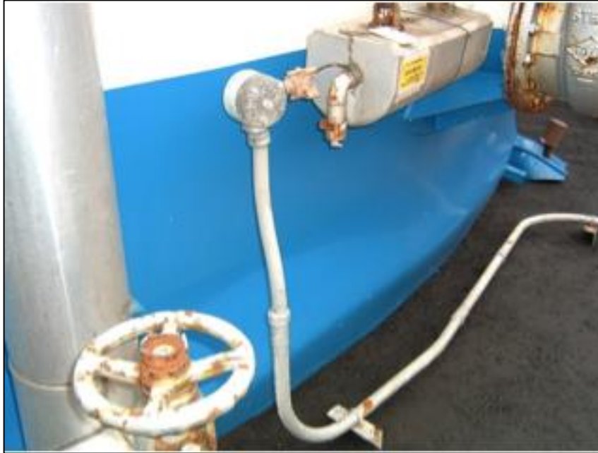
2. ábra Duktilis tartályanyag elefántláb-kihajlása (Kashiwazaki-Kariwa Atomerőmű)
