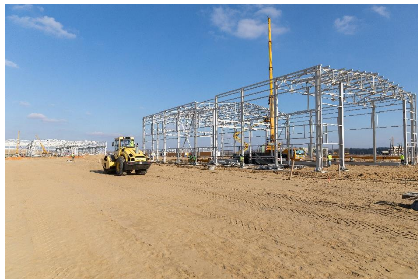
Az acél- és betonacél-szerelő üzem létesítése.
